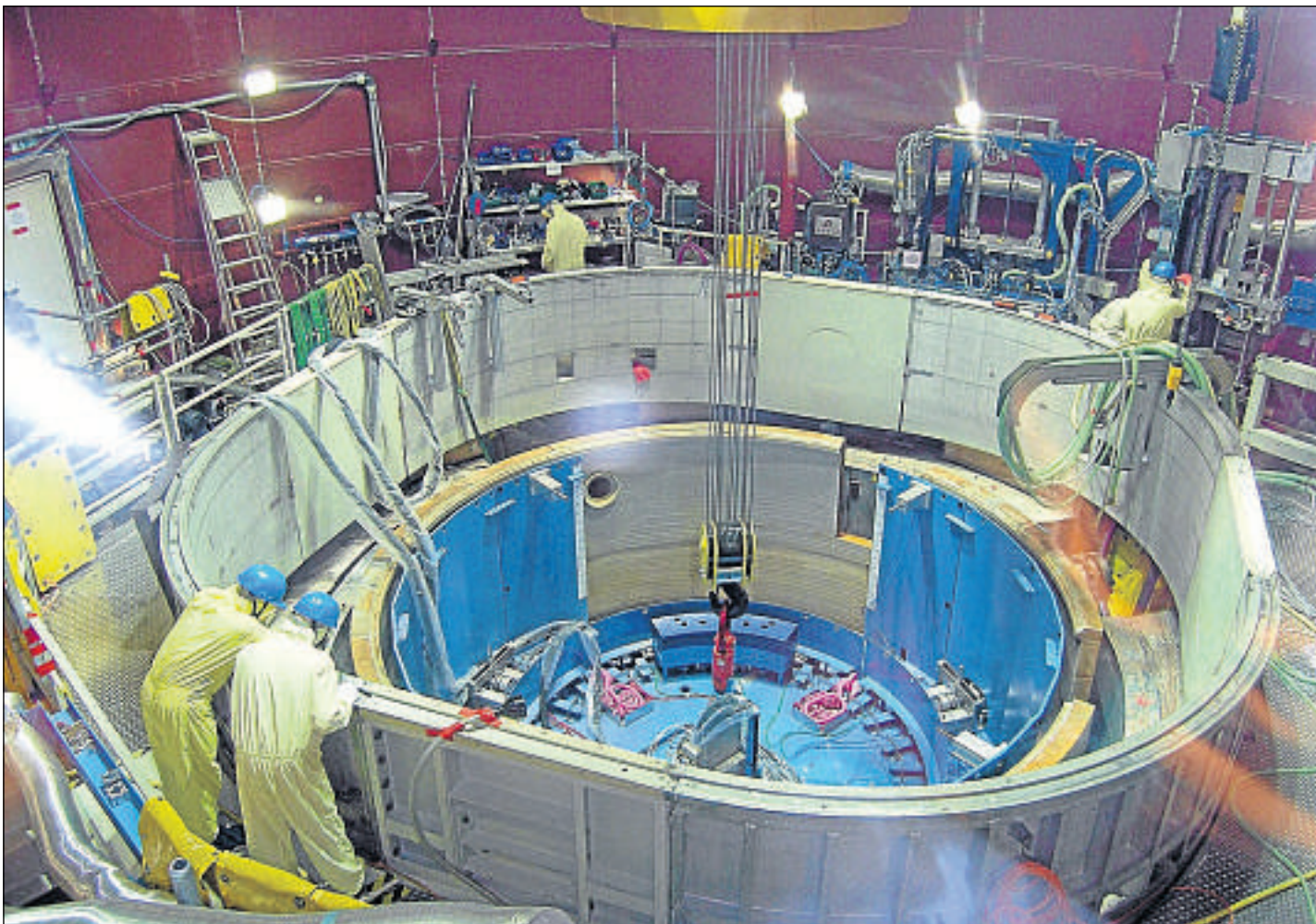
Blick ins Innere des stillgelegten Atommeilers: Unser Bild zeigt die Abrissarbeiten am Reaktordruckgefäß im KKW Würgassen. Foto: Eon
